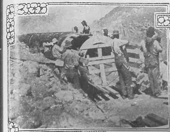
Colocación de la tubería de madera al través de una región montañosa a miles de pies de elevación.
