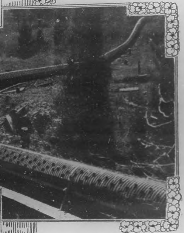
Tubería de madera de 14 pies de diámetro, la mayor del mundo, en el Estado de... para mover las locomotoras eléctricas más potentes que se conocen. Este sistema de tubería de madera lo cometrará el Sr. Blanco Herrera a la construcción del Gobierno cubano para ampliar rápidamente el servicio de agua de la Habana.
